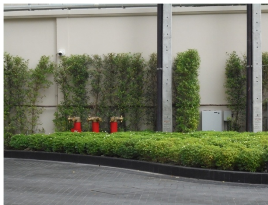
ภาพที่ 3-28 หัวรับน้ำดับเพลิงจากภายนอกและจุดรวมพล
