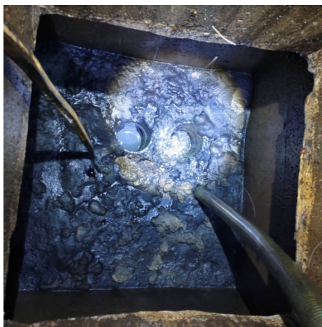
ภาพที่ 3-41 ดูแลซ่อมบำรุงระบบบำบัดน้ำเสียและสูบน้ำที่บ่อพักตะกอน
